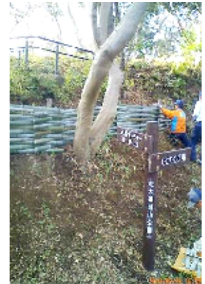
間伐竹を使ったシガラ設置
